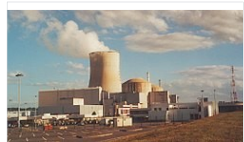
Kerncentrale Civaux van Électricité de France te Civaux in Frankrijk. Zichtbaar zijn een koeltoren en twee reactorhoepels.
