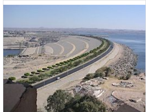
De Aswandam in Egypte is een gewichtsdam
